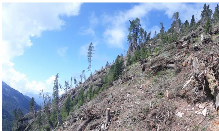
Cantiere di rimboschimento a Pampeago
