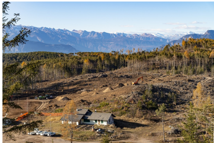
Lavori di ripristino e rimboscimento presso il cantiere campione di Bedolpian
