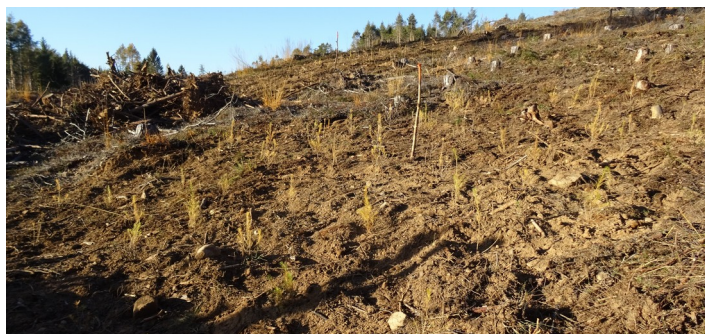
Impianto collettivo di larice - cantiere di Bedolpian
